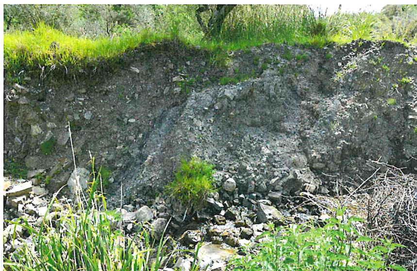
Fot.7 – Forme di erosione lungo le sponde nell'ambito dei depositi di frana attiva
